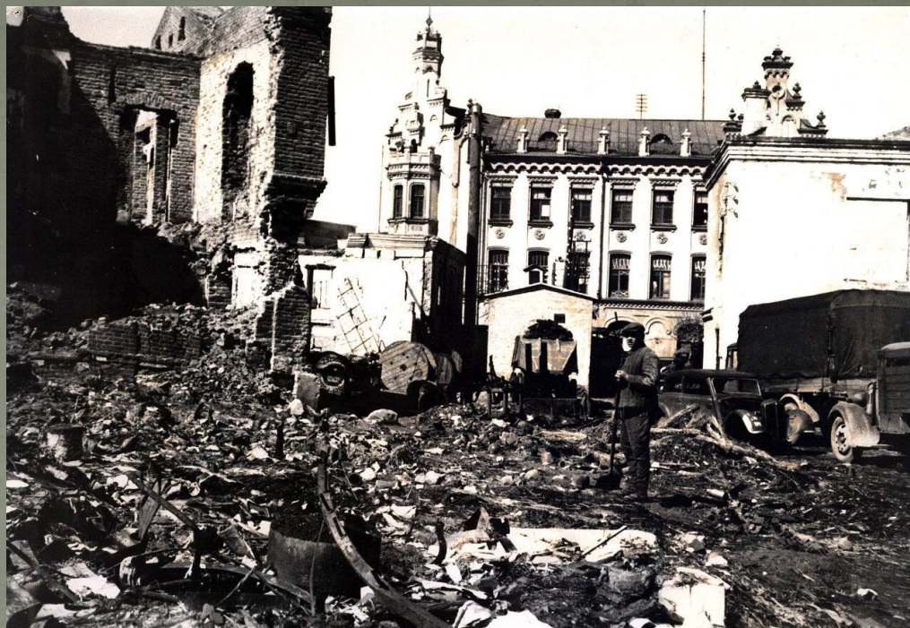
Разрушения у здания Главпочтамта (ныне - гостиница "Центральная").
